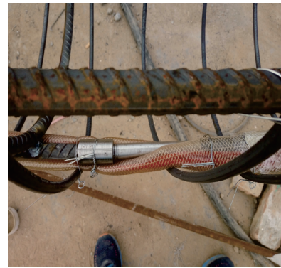
图8 钢筋计导线保护
